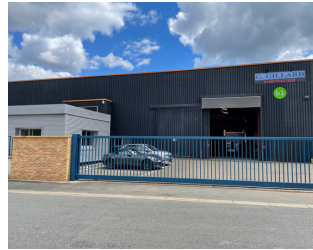
Atelier de chaudronnerie
