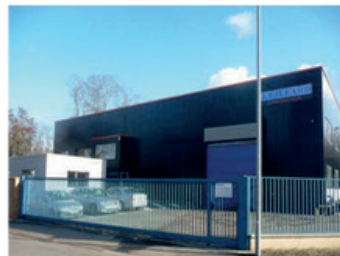
Atelier de chaudronnerie
